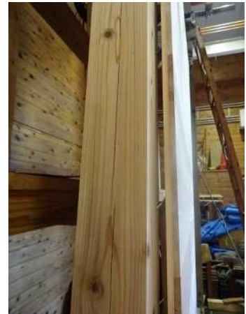
写真-6 釘の引抜け状況
