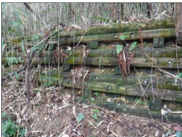
写真-1 ウッドブロック設置状況
