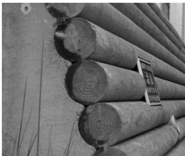
写真-1 残置型枠の端部
