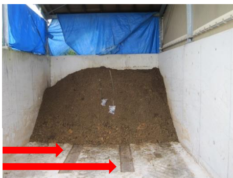
下部から送風できる堆肥舎
