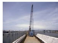
一色漁港海岸(西尾市)
