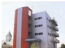
津波避難ビル (弥富市南部地区防災センター)
