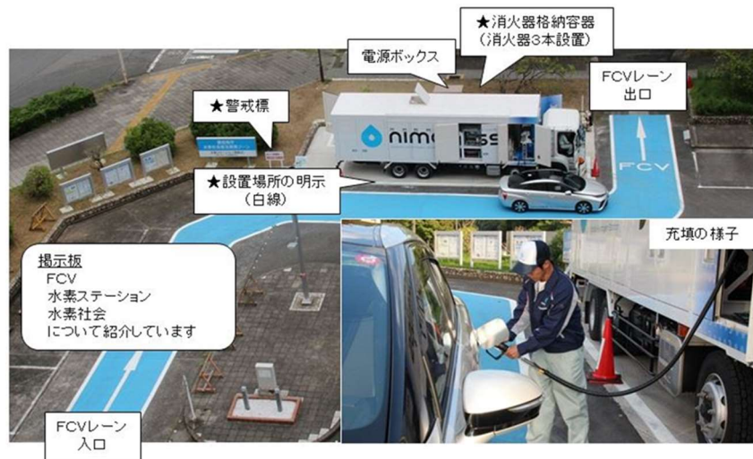
愛知県庁水素社会普及啓発ゾーン（全景）
