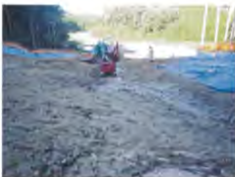
【自然流路の掘削状況】
