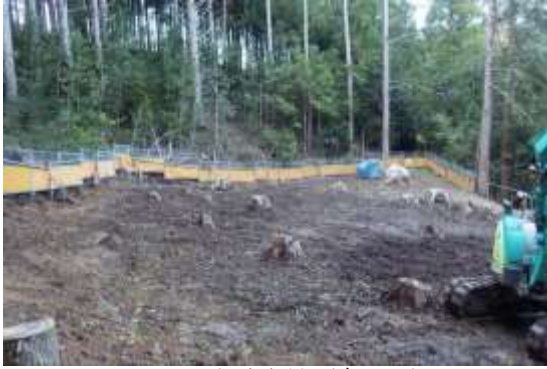
調査前全景 (南から)
