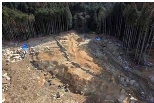
写真8 C区全景 (北から)
