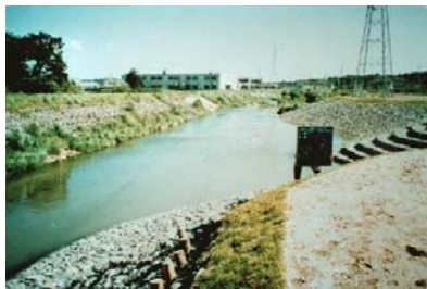
鞍流瀬川（大府市）工事完了直後
