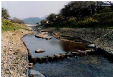
朝倉川（豊橋市）工事完了直後
