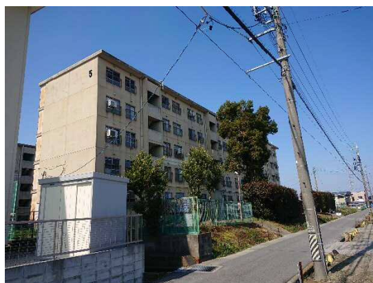
南西方より調査対象地（5棟など）
