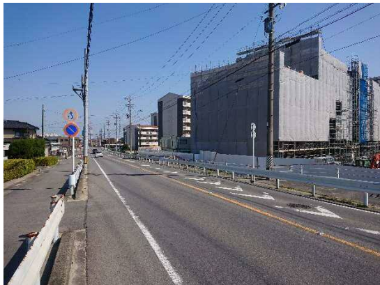
南西方より調査対象地
