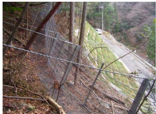
落石を防ぐ落石防護網工
