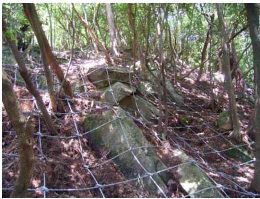
不安定な岩を固定するロープ伏工
