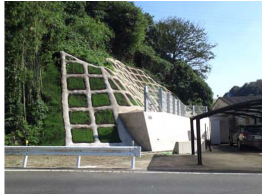
土留工と法枠工による復旧工事完了後
