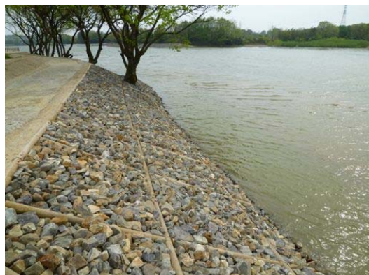
水環境整備事業勅使池地区 緩勾配護岸
