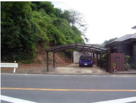
山腹崩壊が発生した工事着工前
