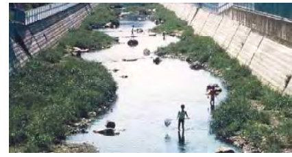
水際の寄せ土・寄せ石で蛇行を形成した事例 (いたち川・横浜市) (写真提供: 吉村伸一氏)
