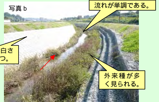
下流の既往改修区間 (低々水路あり)
