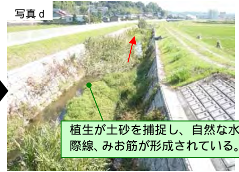
施工 4 年半後（平成 20 年 10 月撮影）
