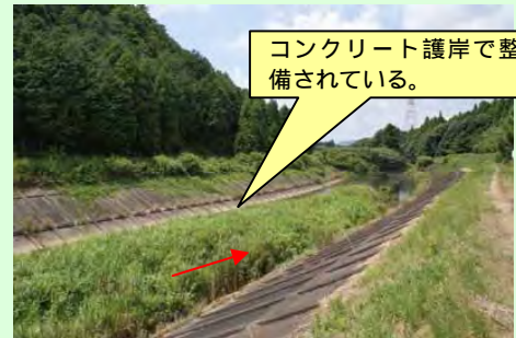
上流の既往改修区間
