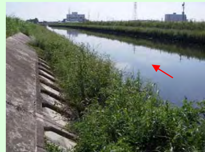
既往改修区間(6/100 付近)
