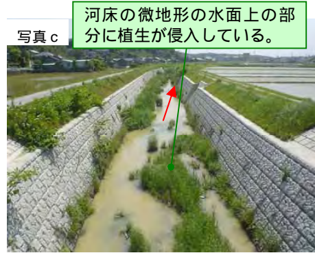
施工 2 年後（平成 18 年 5 月撮影）
