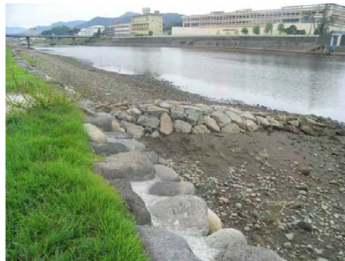
水制による水際の多様化の例（五ヶ瀬川・宮崎県） （写真提供：(株)建設技術研究所）
