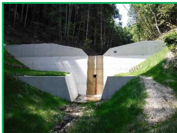
山を守り水を蓄える治山ダム(公共事業)
