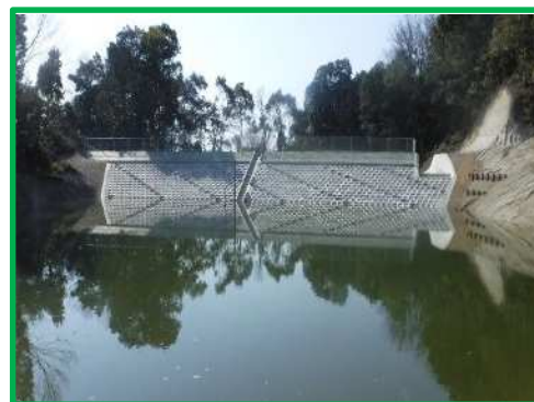
緊急老朽ため池整備事業(折平新池地区)
