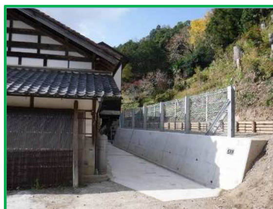
人家を守る治山工事(単県事業)
