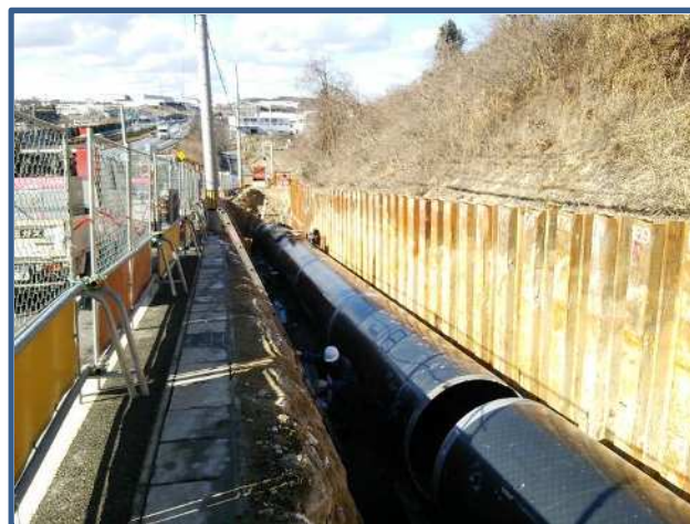
改修中の管水路(東名高速道路沿い)
