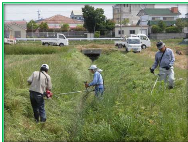
水路法面の草刈
