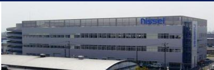
2007年4月竣工の減速機第2工場
