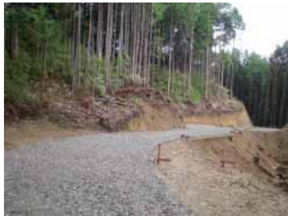
林業専用道の竣工状況
