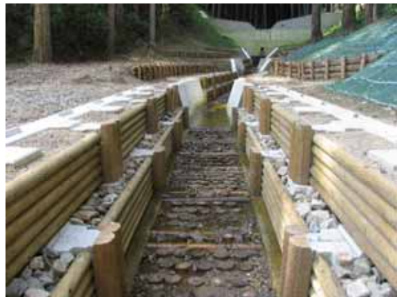
防災効果と環境保全に配慮した治山施設
