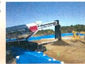
中間貯蔵施設 土壌貯蔵施設
