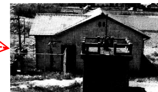
勝賀揚水機場
