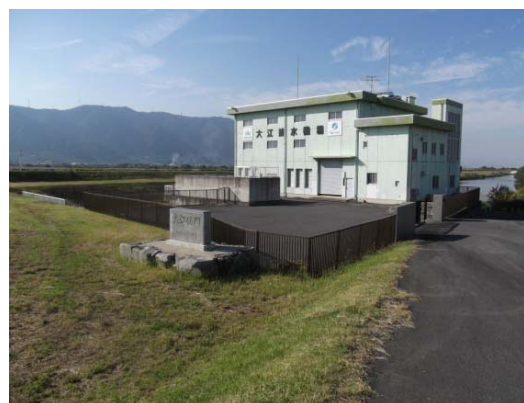
大江排水機場
