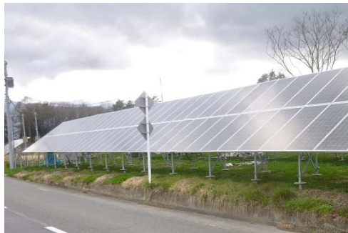
(柵塀未設置の事例)
