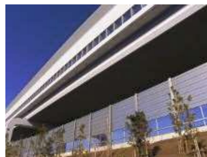
遮音壁の設置事例
