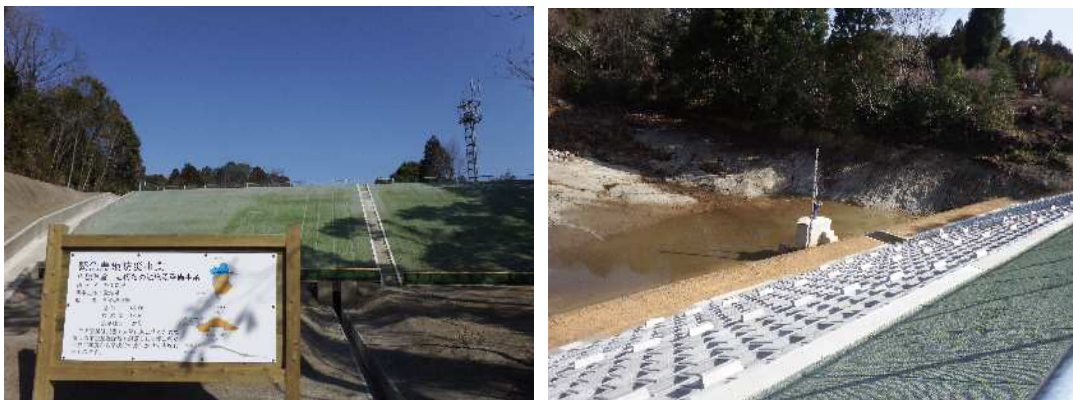
緊急老朽ため池整備事業 折平新池地区 (豊田市)
