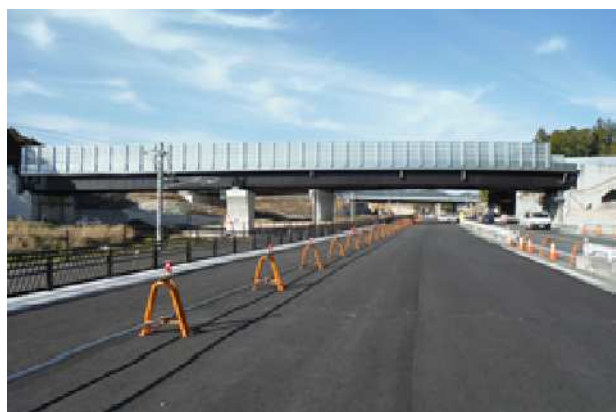
国道151号新城バイパス
