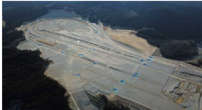
造成工事の一部が完成した東工区の状況
