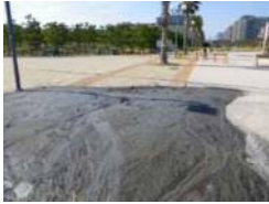
地面から泥水が噴き出します。
