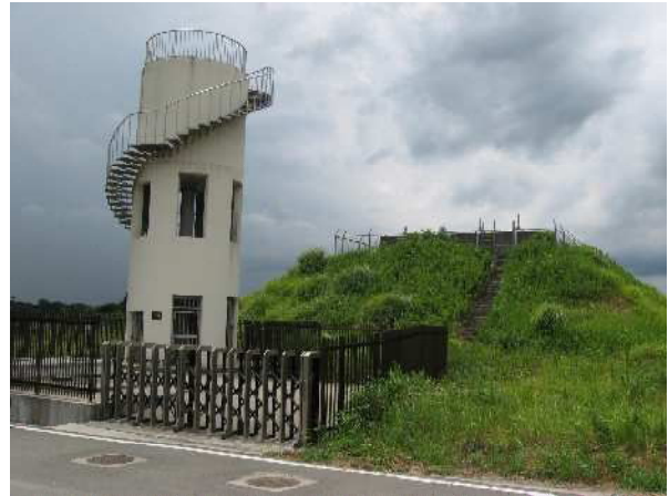
知多常滑線サージタンク
