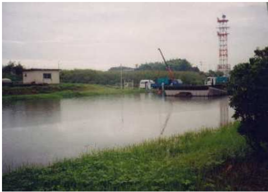
上野浄水場スラジピット冠水状況(9/13)
