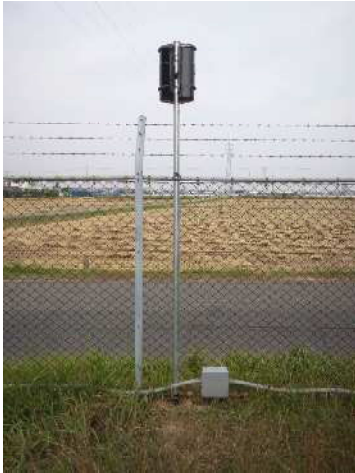
浄水場防犯センサー（赤外線センサー）の一例
