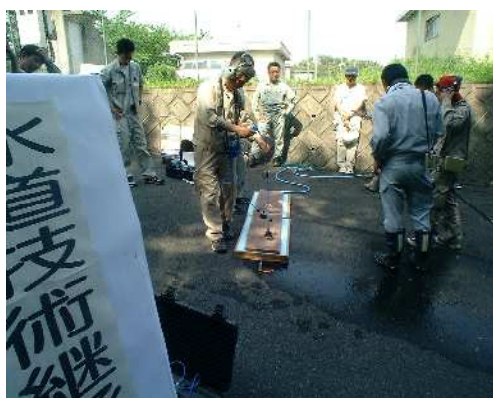
平成22年度水道技術継承研修会 漏水探査の実習状況
