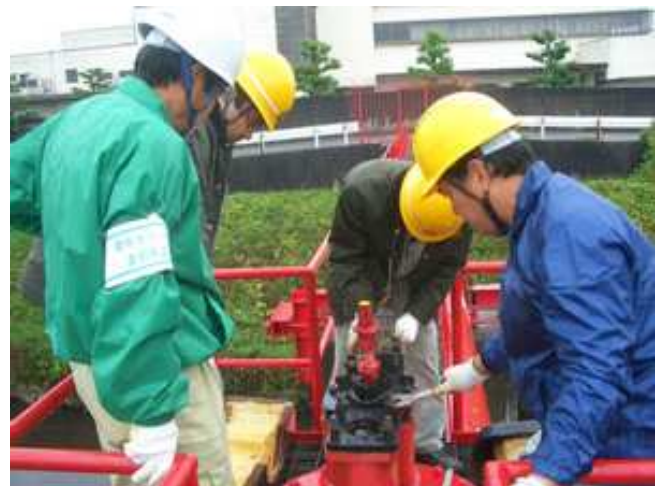
防災訓練 水管橋空気弁解体（尾水事務所班）
