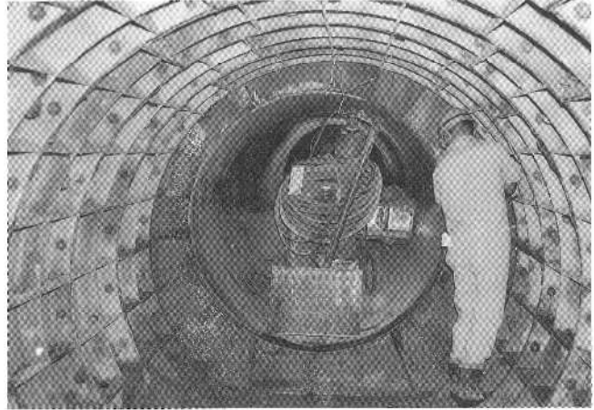
矢作連絡導水路第1号トンネル鋼管布設工事
