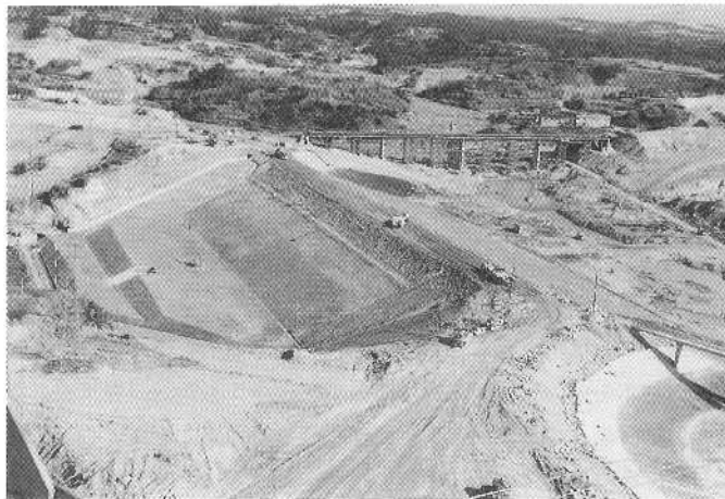
建設中の佐布里池
