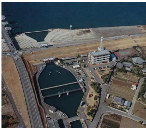
木曾川大堰上流左岸側取水施設
