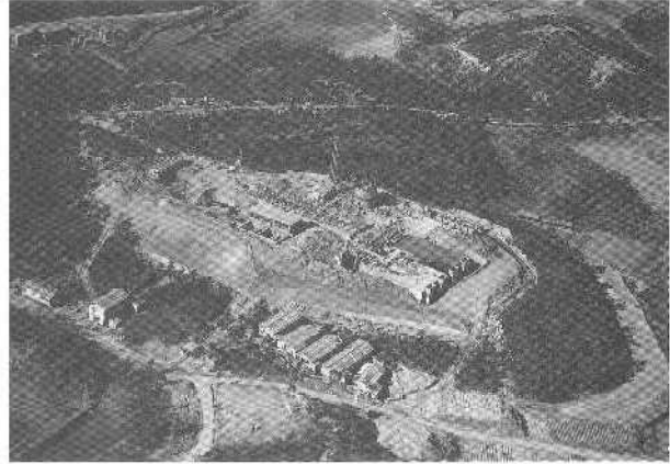
建設工事中の久米浄水場
