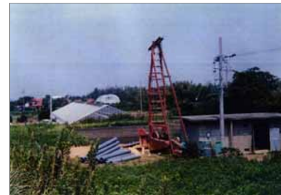
応急井戸掘りのようす（平成6年の渇水）
