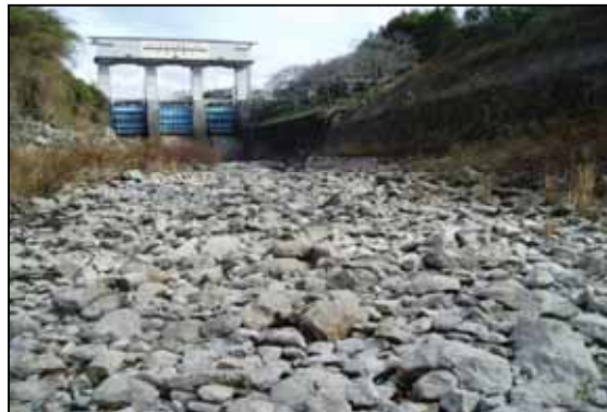
大野頭首工下流の「瀬切れ」の状況 (平成16年12月)
