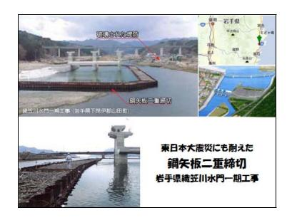
詰材に用いられた骨材が一部失われただけで、締切堤としての機能は失われなかった。
