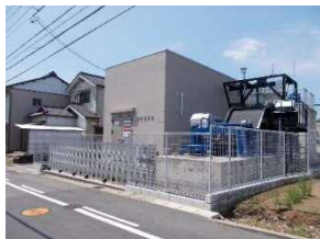
イ.向町ポンプ場
