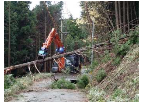
市道沿いの間伐後 危険木の除去
