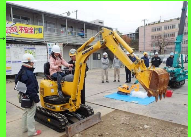
見学者による 建設重機の操作体験
