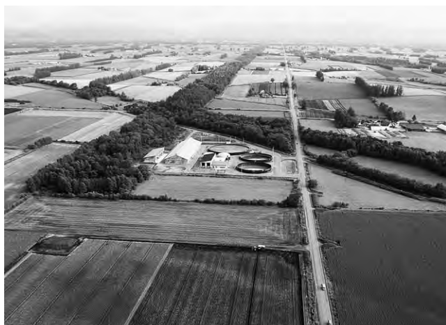
鹿追町環境保全センターの全景。約5.2ヘクタールの中にバイオガスプラント、堆肥化プラント、コンポスト化プラントがある。
