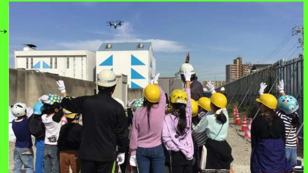
ドローンによる空からの建設現場の見学
