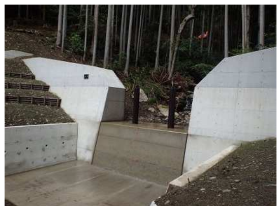
流木捕捉式治山ダム
