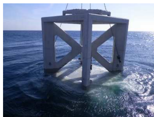
魚礁漁場の整備のため海中に沈められる コンクリート製魚礁
