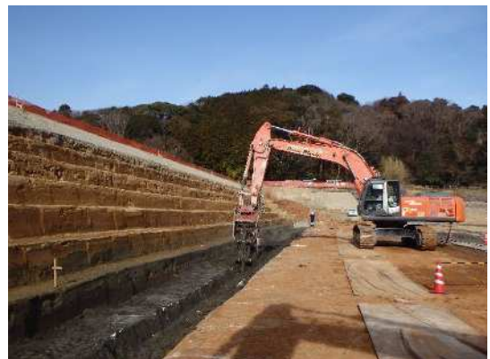
地盤改良によるため池の耐震対策
