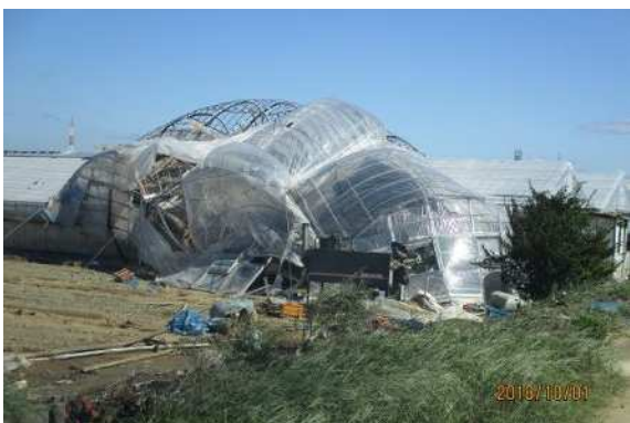
大型台風による園芸施設の倒壊
