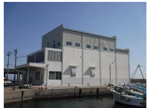
整備された製氷・貯氷施設
