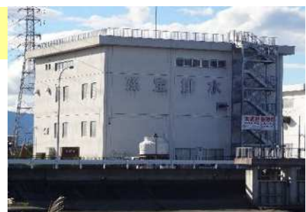
ゼロメートル地帯の排水機場に 設置された緊急避難用の階段
