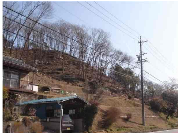
竹林・森林整備、筋工設置
