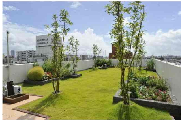
屋上緑化（名古屋市）
