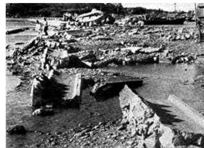
昭和28年台風13号による被害
