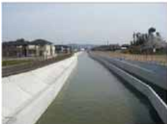
国営総合農地防災事業 新濃尾地区 (工期 H10～26)
