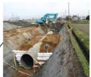
かんがい排水事業 村高地区(工期 H18～27)
