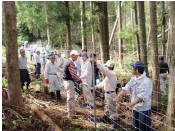
防止柵設置状況
