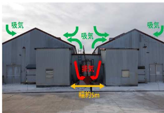
図1 発生農場の吸排気システム
