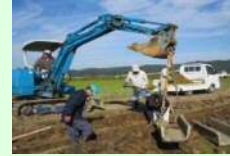
コンクリート水路の更新
