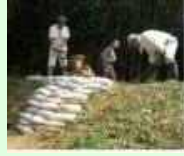
漏水箇所の補修
