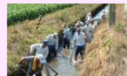
水路の泥上げ
