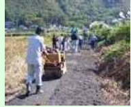
未舗装農道の舗装
