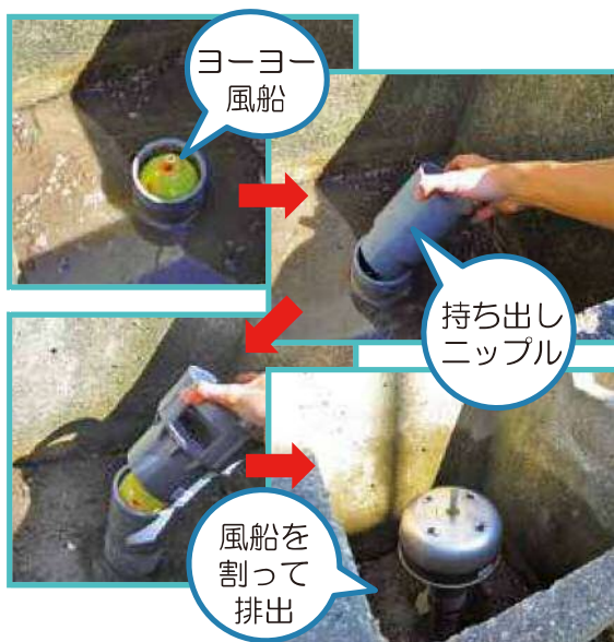
農業用水の給水栓補修
