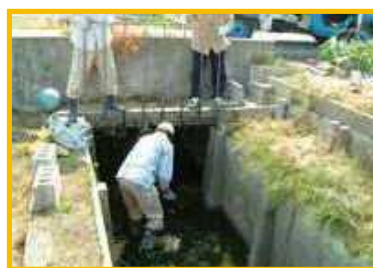
水路の泥上げ
