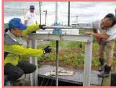
ゲートの点検・補修
