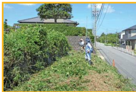
ため池堤体の草刈 作業前
