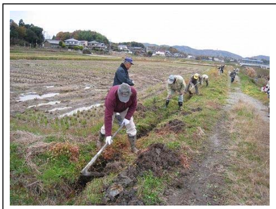
農道側溝の泥上げ
