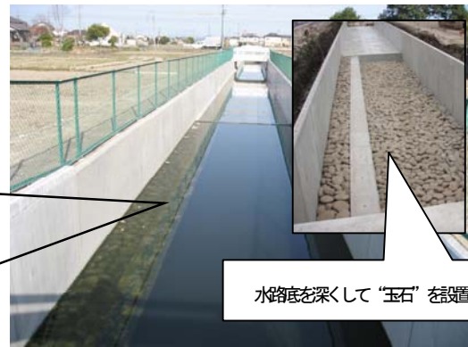
大江川上流地区で整備した排水路 「魚だまり」設置部
