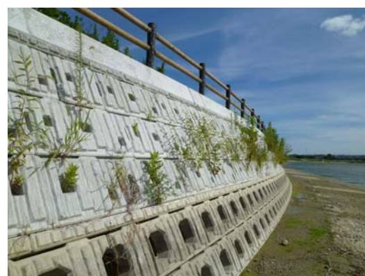
水環境整備事業勅使池地区 緑化ブロック護岸
