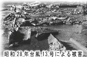
昭和 28 年台風 13 号による被害
