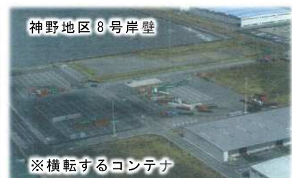
2009年台風18号による三河港の被害状況
