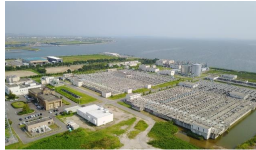
矢作川浄化センター
