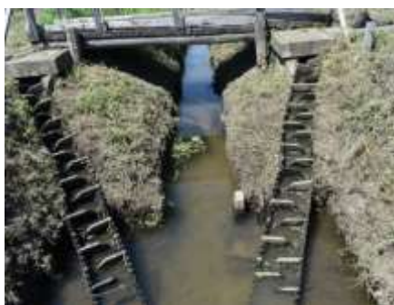
水田に設置された魚道
